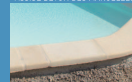
POSE DES MARGELLES
