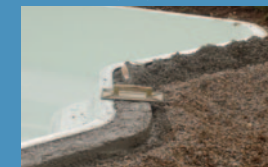
ASSISE BÉTON DES MARGELLES
